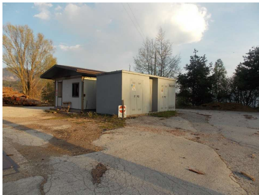
Figura 14: Cabina di media tensione attualmente presente nell'area
